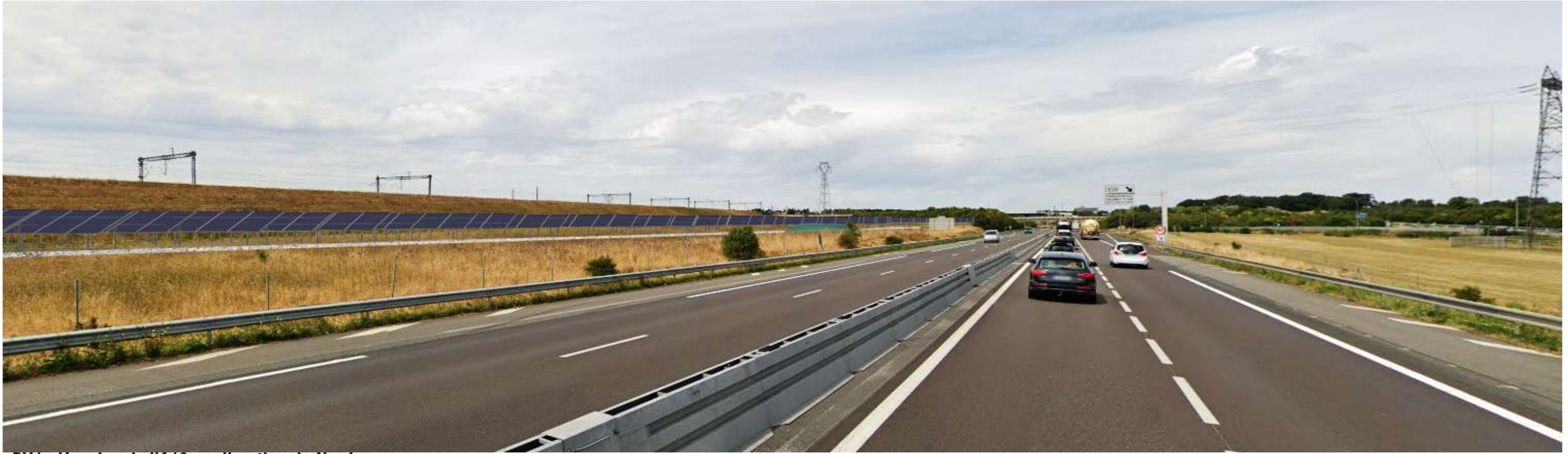
PV1 - Vue depuis l'A10 en direction du Nord
