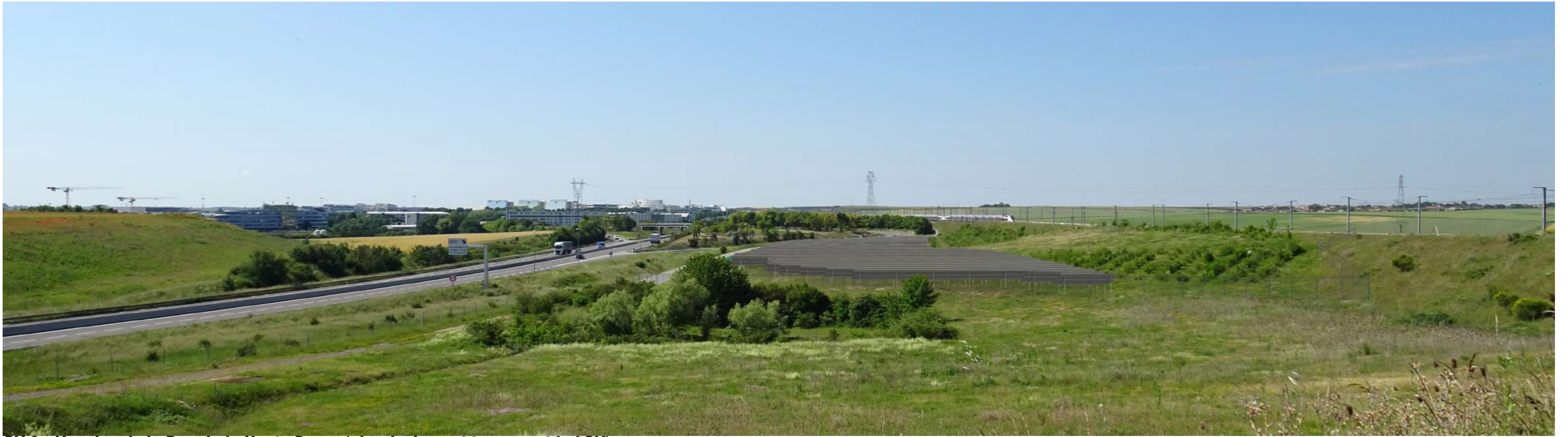
PV 3 - Vue depuis la Rue de la Haute Payre (abords du pont traversant la LGV)
