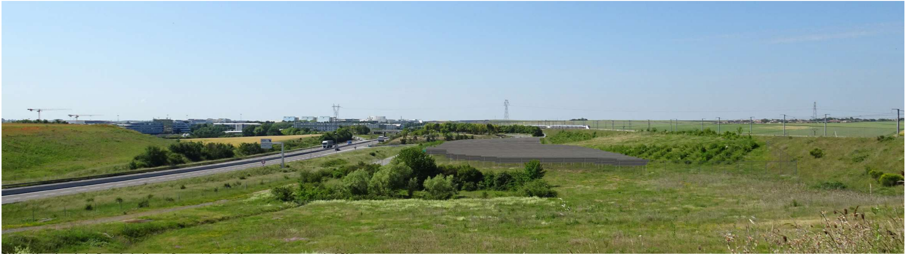
PV 3 - Vue depuis la Rue de la Haute Payre (abords du pont traversant la LGV) - avec mesures paysagères
