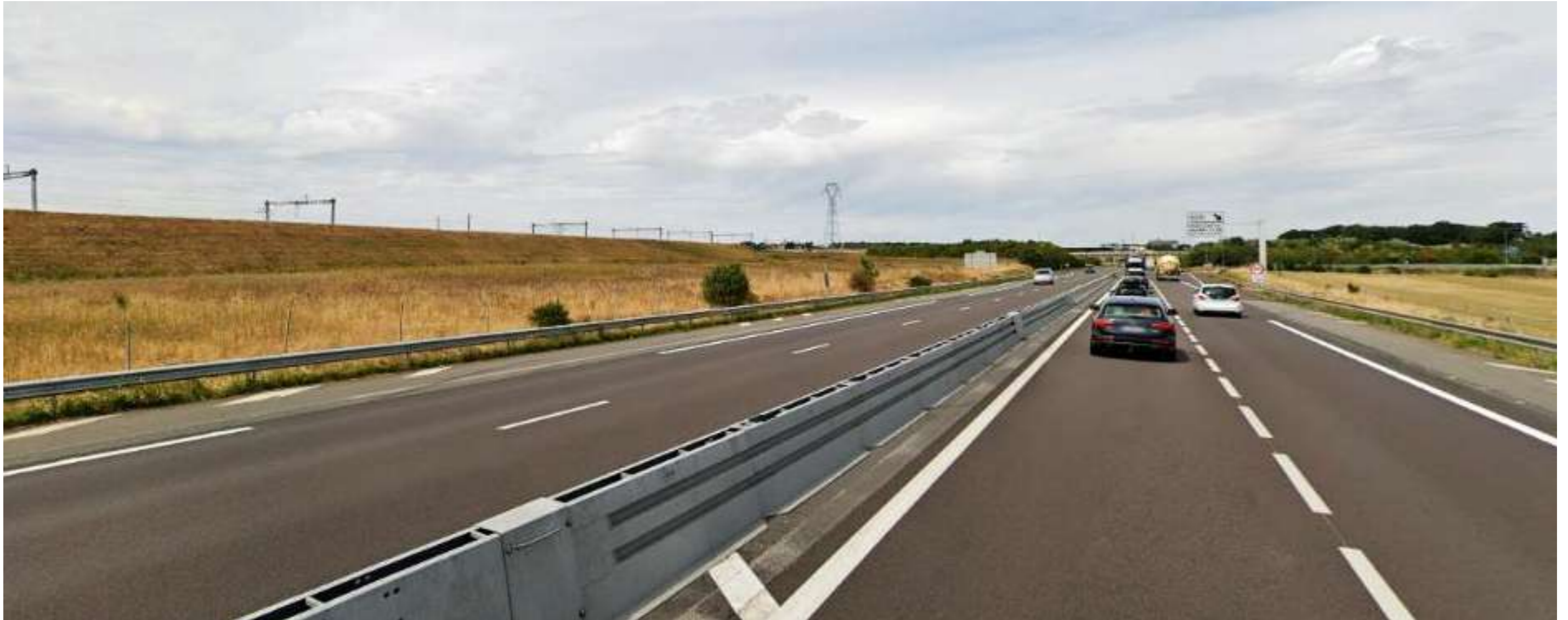
PV1 - Vue depuis l'A10 en direction du Nord
