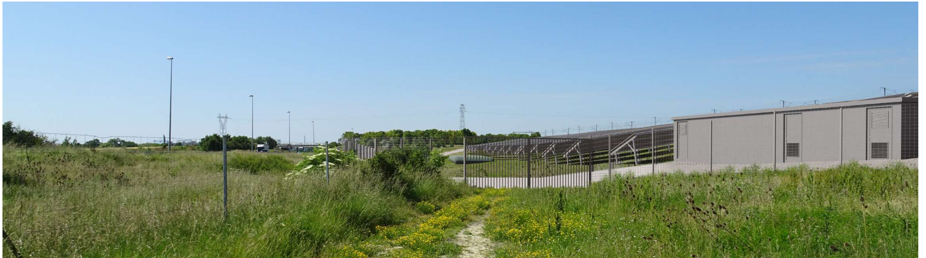
PV 4 - Vue depuis la piste existante au nord du projet
